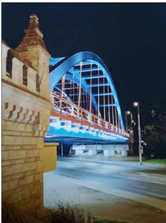
Nowy wiadukt kolejowy przy ul. Grabiszyńskiej, Kajetan Jakubiak, II c, Wrocław
